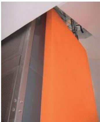
Jedes Liftschachtgerüst ist im oberen Bereich mit einer ausreichend dimensionierten Entlüftungsöffnung ausgestattet. Diese ist abhängig von der Grundfläche und der Förderhöhe der Anlage.
