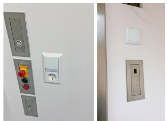
Tür zusätzlich mit Integrierte Fluchtweg-sicherung Zeitsteuerung
