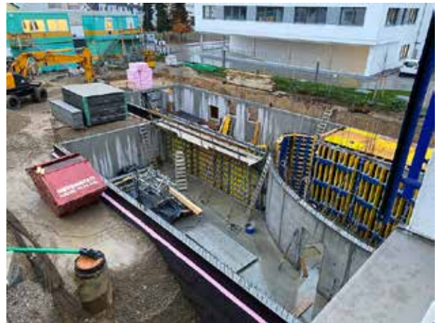
Rund um den Keller ist die Baugrube an vielen Stellen schon wieder verfüllt – und bietet zusätzlichen Lagerplatz für das Baumaterial. An einigen Stellen wurde bereits mit der Verschaltung für die Kellerdecke begonnen.
