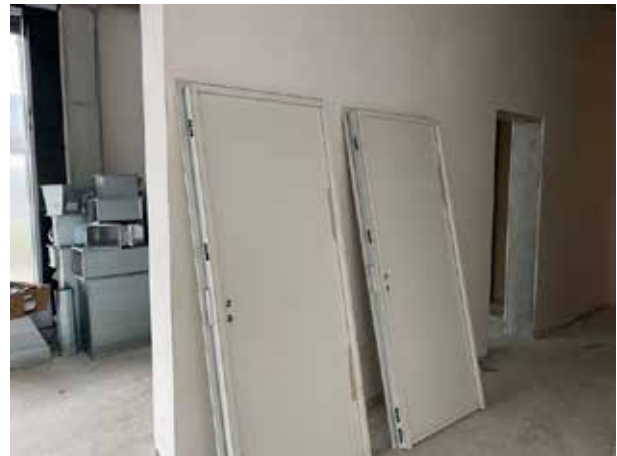
Und die Brandschutztüren werden auch montiert. Im Erdgeschoss warten sie noch auf den Einbau.
