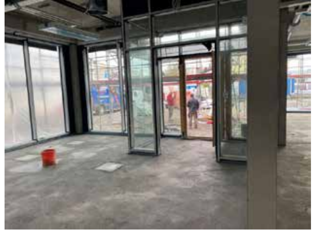
Im gesamten Erdgeschoss wurde der Estrich verlegt. Die Räume lassen immer mehr erahnen, wie sie später mal aussehen werden. Hier der Blick von innen auf den Eingangsbereich.
