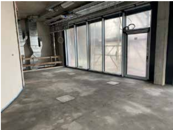
Und von der gleichen Stelle nach hinten in Richtung Treppenhausellipse photographiert.
