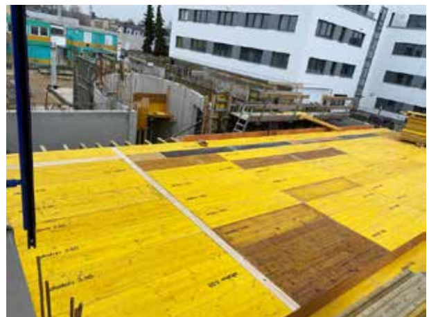
Im Lagerbereich liegen die Verschalbretter für die Decke des Erdgeschosses schon an Ort und Stelle.
