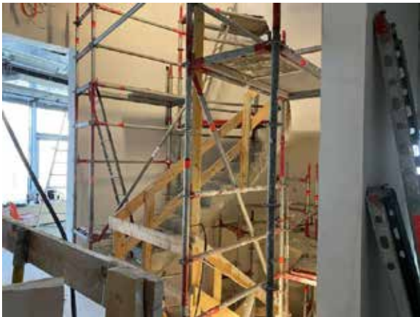
Das Treppenhaus ist vorübergehend nicht passierbar, da ein Gerüst zum Verputzen aufgestellt wurde.
