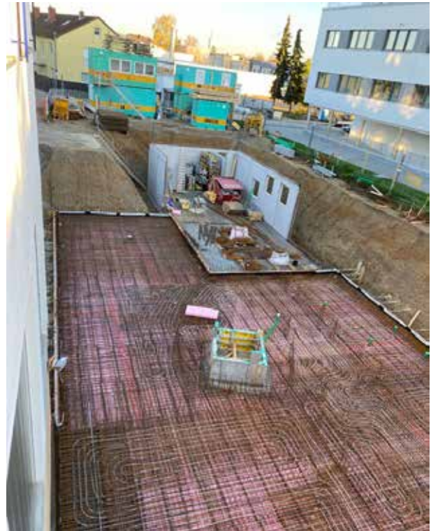
Alles fertig zum Betonieren des hinteren Kellerbereichs.
