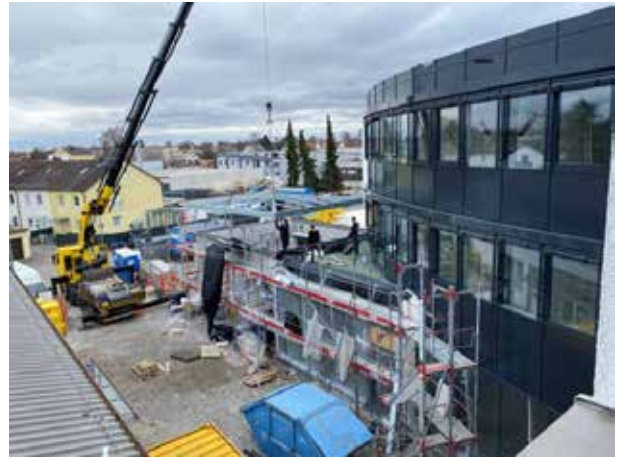
Über den Eingangsbereich kommt ein großes Glasdach, damit auch jeder, der zu uns kommt, auch vor dem Gebäude ein trockenes Plätzchen findet. Die Stahlkonstruktion zur Aufnahme der Glasplatten wird "eingeflogen".
