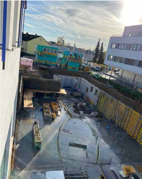
Die restlichen Außenwände werden geschalt und gegossen.
