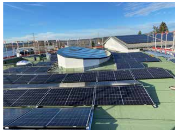
In der letzten Woche vor Weihnachten zeigt sich das Wetter gnädig: die PV-Anlage kann noch installiert werden.
