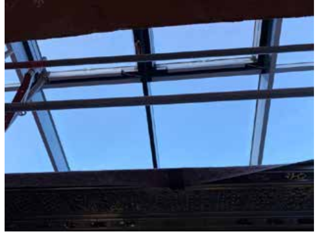
Noch kann man das Glasdach von innen nicht in voller Pracht sehen, da ein Gerüst darunter steht.
