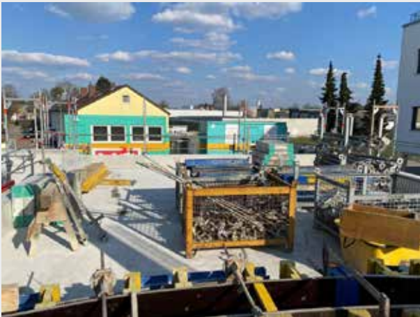
Wo jetzt Gitterboxen und Baumaterial Platz finden, wird eine Dachterrasse direkt vor dem Aufenthaltsraum entstehen.
