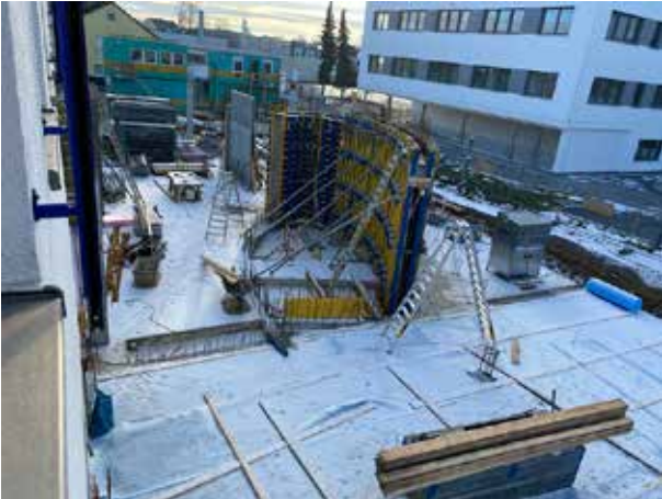
Die Baustelle ist noch etwas verschneit.
