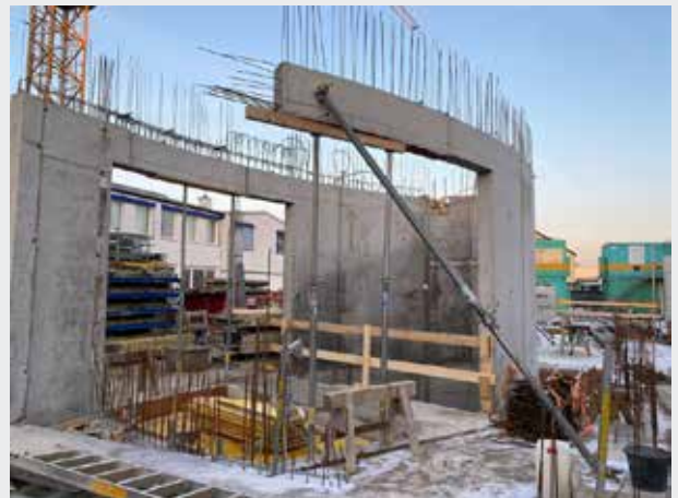
Die Treppenhaus-Ellipse von der anderen Seite.
