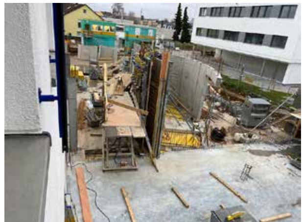
Noch einmal ein Blick von hinten in das zukünftige Treppenhaus. Es fehlt nur noch an einer Stelle die Außenverschalung, so dass bald mit dem Betonieren der Treppenhauswand begonnen werden kann. Das Erdgeschoss nimmt Formen an und bald müssen die Baustellenfotos dann wohl aus dem 2. Stock des Altbaus gemacht werden.
