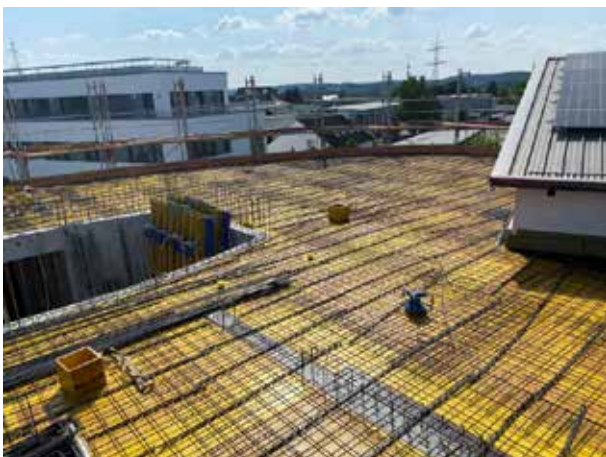
Über der Treppenhausellipse wird nichts verschalt – denn dort ist das Dach verglast, so dass immer viel natürliches Licht ins Treppenhaus gelangt.
