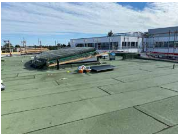
Noch fehlen die Glasscheiben, sodass die Rahmenkonstruktion noch einmal wetter- und regenfest eingepackt werden musste.
