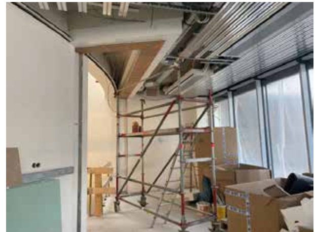
Jetzt ist auch der Feuerschutzvorhang eingebaut, so dass jetzt auch in dem hinteren Bereich die Decke fertig gestellt werden kann.
