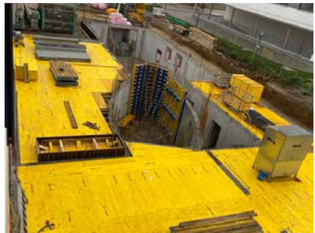
Alle Kellerinnenwände einschließlich der komplizierten Treppenhaus-Ellipse sind fertig und ein großer Teil der Kellerdecke ist bereits verschalt.
