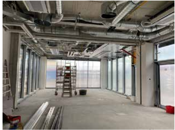
Im Multifunktionsbereich wird noch mit der Verlegung der Heiz-/Kühldecke begonnen.
