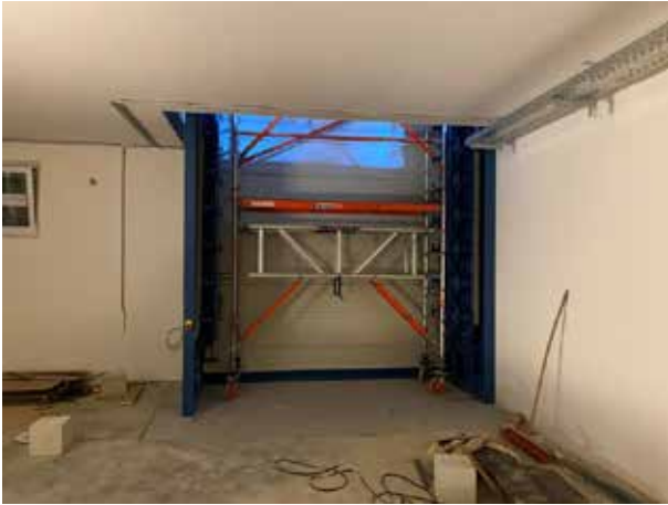
... und hier im Keller.
