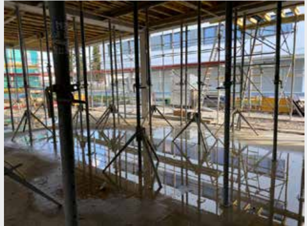
Vom Eingangsbereich geht es nach links in den großen Schulungs- und Tagungsbereich. Auch hier sorgen große Fenster für viel Licht.
