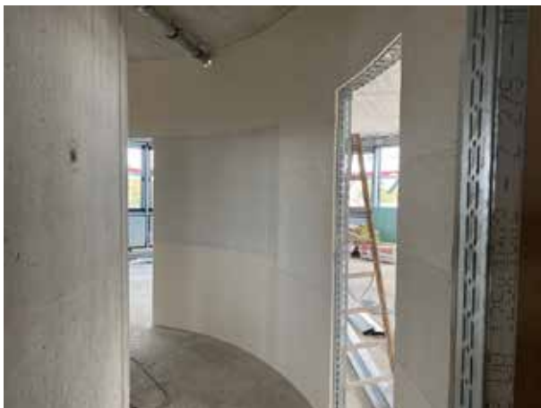
Der Gang läuft entlang der Treppenhausellipse
