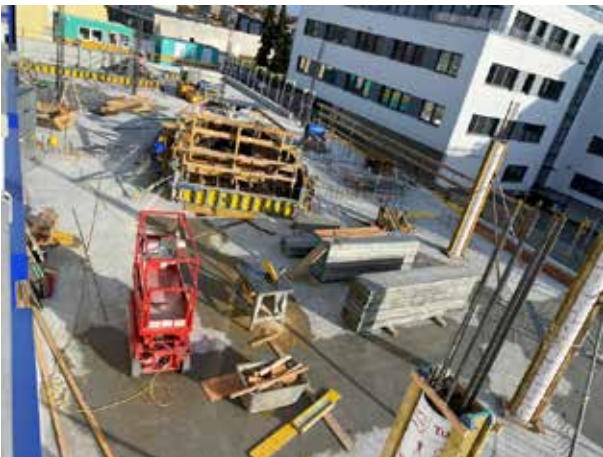
Im vorderen Bereich sind die Stützen noch nicht verschalt.
