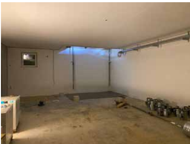
Hier wird unser Lagerautomat seinen Platz finden, der über zwei Stockwerke geht (Keller und Erdgeschoss)
