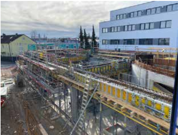
Die Unterzüge sind betoniert. Jetzt muss deren Verschalung entfernt werden, damit auch in diesem Bereich die Deckenschalung angebracht werden kann.
