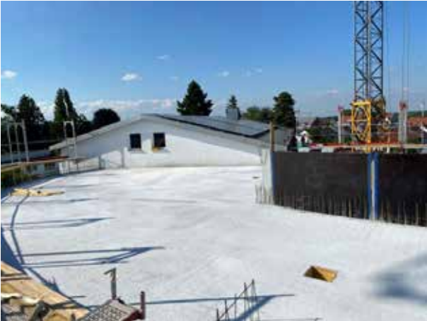
Die Decke auf dem zweite Stock ist fertig.
