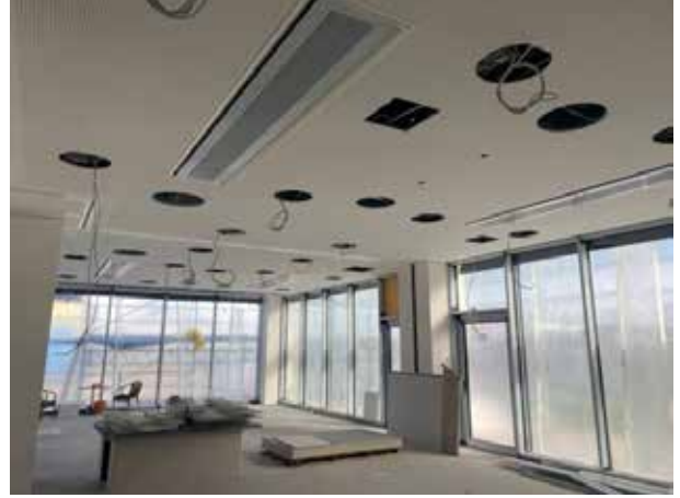
Etwas später ist die endgültige Schallschluckdecke montiert.
