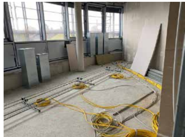
Im 1. Stock werden immer noch weitere Leitungen und Kabel am Boden verlegt.
