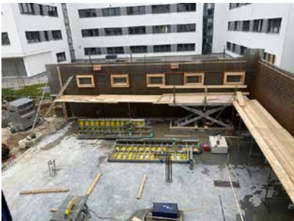
Der hintere Bereich des Erdgeschosses wird Lager. Daher sind dort auch Verschalungen zum Betonieren der Außenwände nötig. Die Stahlflechter sind schon fast fertig, so dass in der kommenden Woche bald die Innenseiten der Verschalung angebracht werden können.
