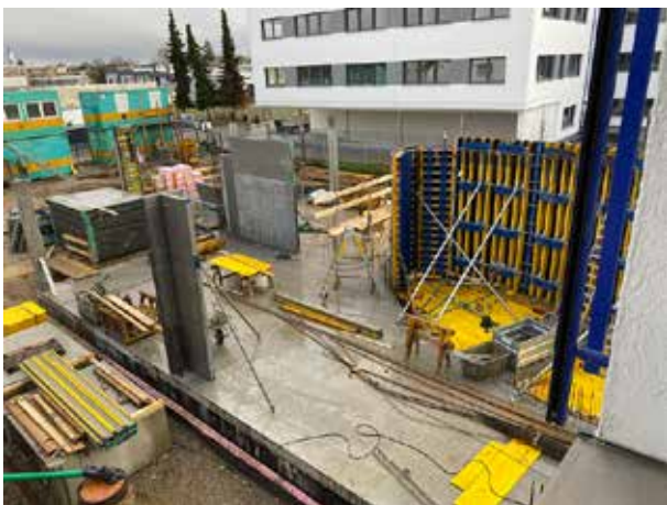
Die ersten Säulen für den großen Schulungs- und Konferenzraum stehen (links oben)
