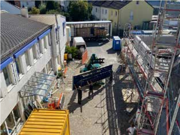
Die fast 7 m langen Seitenteile des Lagerautomaten müssen zum Einbauort transportiert werden – kein leichtes Unterfangen.
