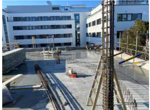
Als nächstes entstehen die Stützen, die die Decke des 1. Stockwerkes abstützen.
