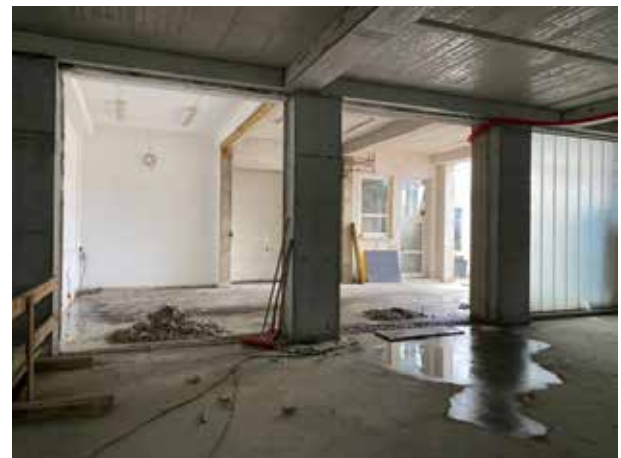
Der Anschluss des neuen Lagers an das alte Gebäude ist bis auf ein altes Wandelement, das noch entfernt werden muss, offen. Anschließend muss noch der alte Teerbelag herausgebrochen werden und eine neue Bodenplatte erstellt werden.
