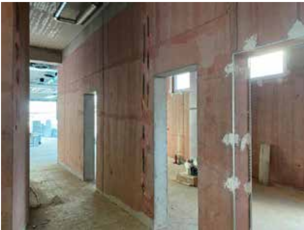
Auch im Erdgeschoss sind bereits alle Betonwände grundiert.
