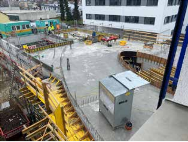
Die Decke ist fertig betoniert – und jetzt sieht man die Ellipsenform bereits deutlich.
