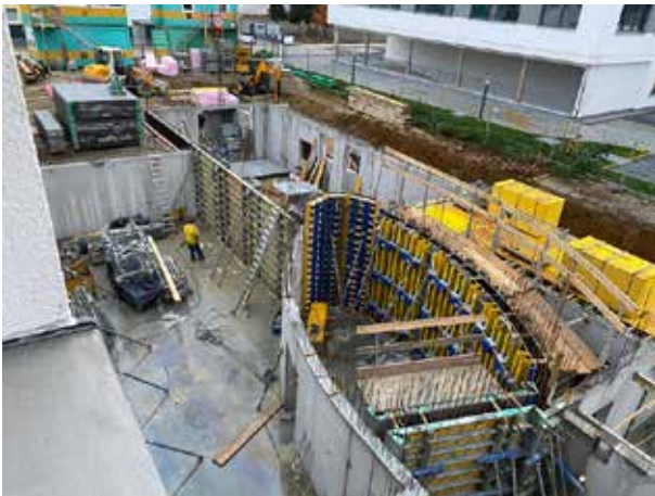
Die noch verbleibenden Kellerinnenwände sind verschalt – fertig zum Betonieren.
