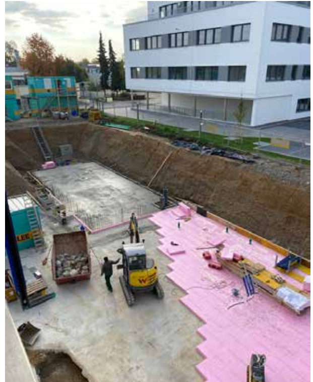
Und schon ist die Bodenplatte fertig.
