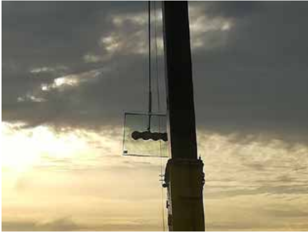
Die Glasscheiben für das Glasdach über dem Treppenhaus fliegen ein. Sie hängen nicht an einem seidenen Faden, sondern an Glassaugnapfen – aber diese halten.
