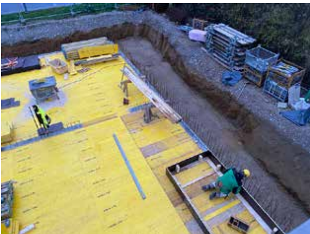
Der Durchbruch in der Kellerdecke zum Erdgeschoss wird geschalt. Hier steht später einmal unser Lagerautomat – damit wir immer genügend Platz für ausreichend Lagerbestand haben und schnell liefern können.
