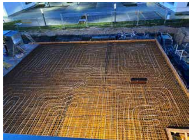
Am 16.1. ist endlich die Kellerdecke im Lagerbereich fertig zum Betonieren vorbereitet. Wird das Wetter mitmachen? Es ist Frost angesagt.
