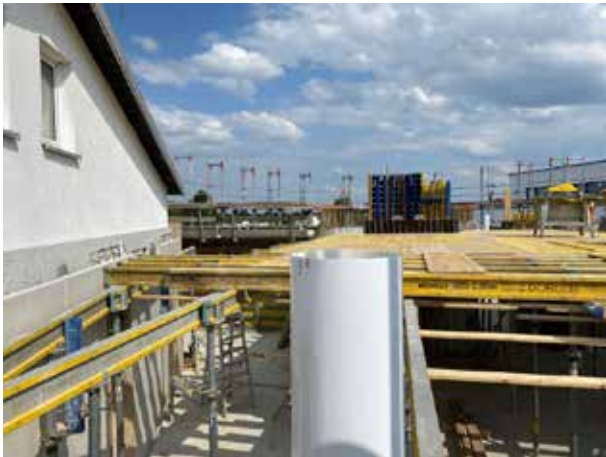
Hier "dockt" der Neubau am Bestandsbau an.
