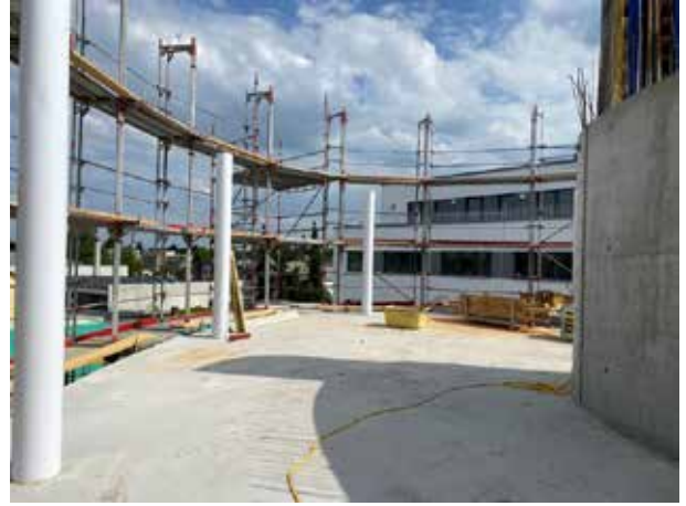
Hier werden mehrere Büros entstehen, alle mit bestem Blick.
