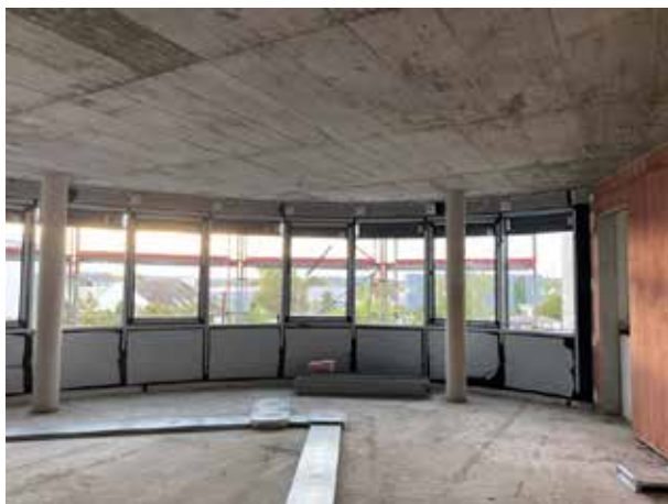
Anhand der viereckigen Auslassdosen kann man sich schon ganz grob vorstellen, wo später einmal Schreibtische stehen werden. An den Fenster kann man außen die montierten Jalousien erkennen.
