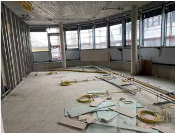
Der spätere Aufenthaltsraum für die Belegschaft, mit eigener Dachterrasse.
