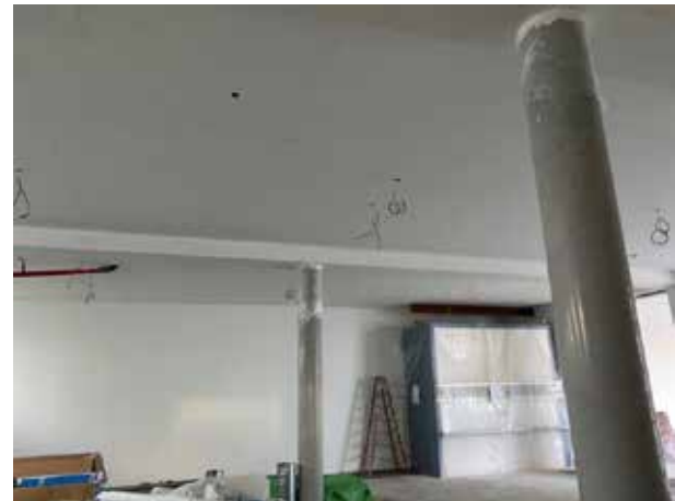
Unser Lagerautomat steht ziemlich unscheinbar hinten in der Ecke des Lagers.
