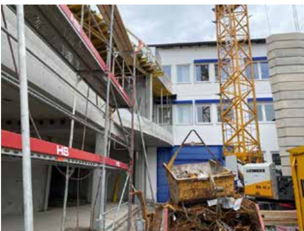
Hier kann man schon erkennen, wo die Ellipse des Neubaus am Altbau "andockt".
