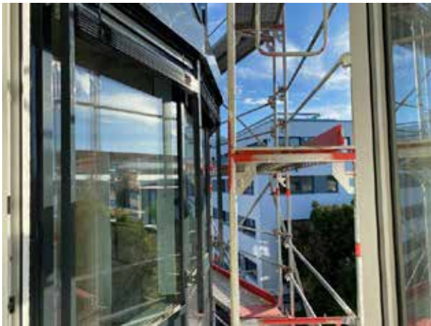
Die Sonnenjalousien werden montiert.
