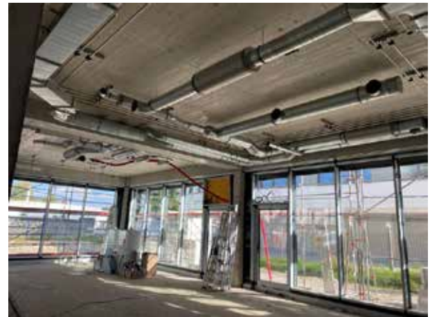
Auch im Multifunktionsraum werden jetzt bereits Lüftungsrohre verlegt
