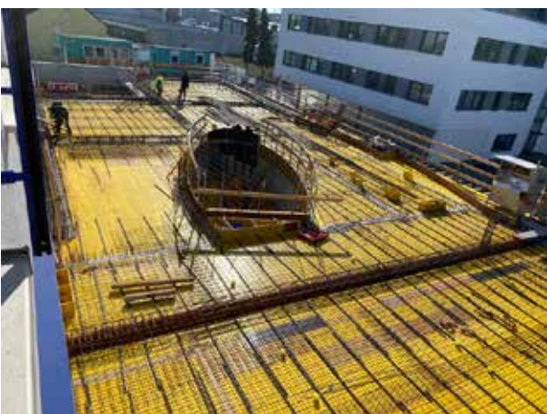
Die ersten von vielen Schichten Baustahl werden verlegt.
