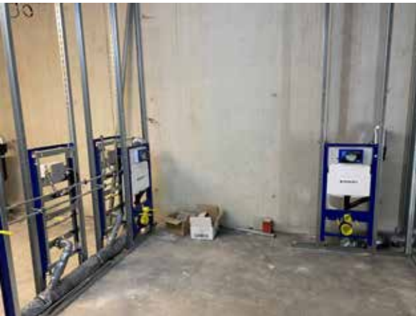
Die Arbeiten an den Toiletten haben schon begonnen.
