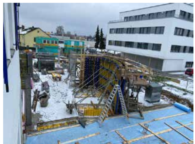
Der Winter ist in Bayern wieder zurück. Aber dennoch wird das Treppenhaus weiter geschalt und am 20.1.23 sogar Beton in die fertig gestellte Verschalung eingefüllt.
