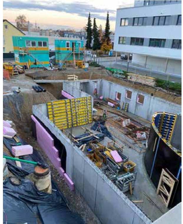
Die Außenwände werden isoliert.
