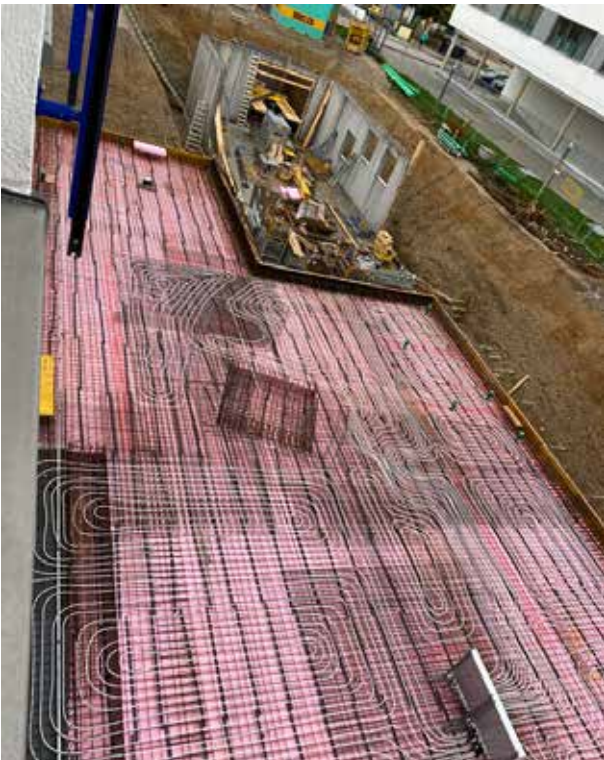
Die Heizschleifen für die Betonkernaktivierung im hinteren Kellerbereich sind verlegt.
