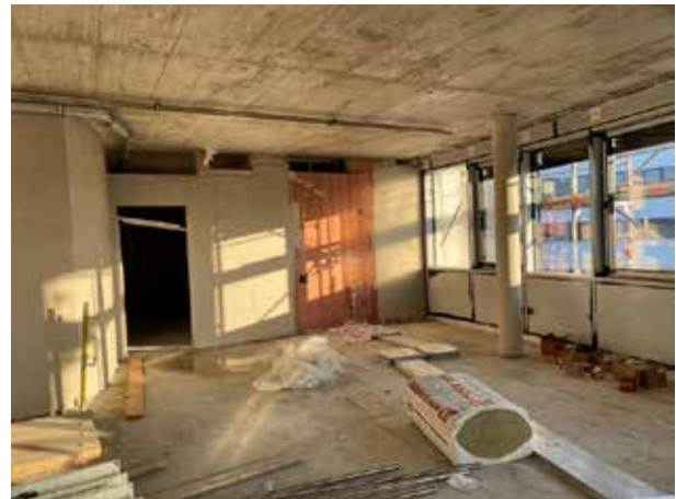
Im 2. OG kommt nur Estrich auf den Fußboden, sodass die Kanäle für die Elektroinstallation am Boden nicht groß auftragen dürfen. Die ersten Wände sind verputzt.
