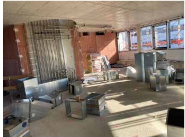
Im Großraumbüro des 1. OGs sind die Betonwände bereits grundiert – und Lüftungskanäle werden montiert.
