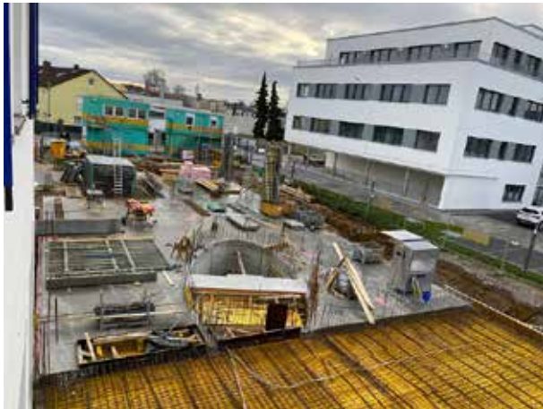
Nach der Winterpause geht es im vorderen Bereich mit Hochdruck weiter. Nur der hintere Lagerbereich wartet immer noch auf die Verlegung der Heizschleifen. Schön zu sehen: das ellipsenförmige Treppenhaus mit der "Brücke", die von einer Seite zur anderen Seite führt.
