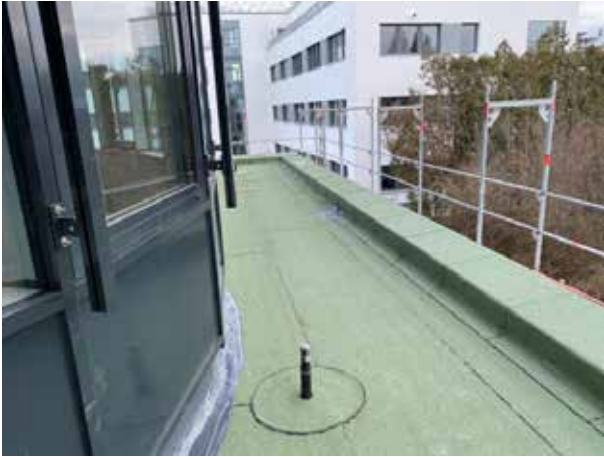
Und jetzt ist alles fertig für das Gründach.
