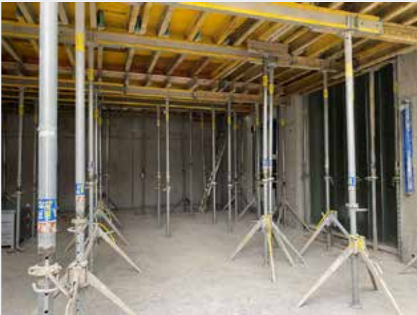
Im Lager – die Verschalung der Decke von unten.
