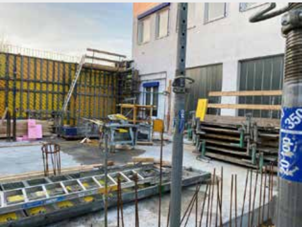
Ein Blick in den Lagerbereich des Anbaus – noch kann man durch die Wände schauen.
