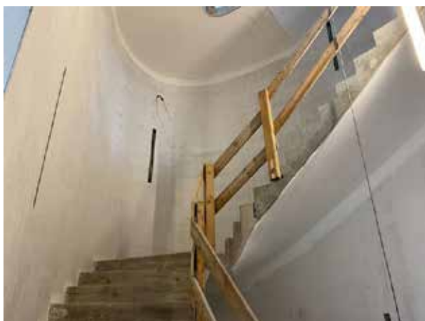
Das Treppenhaus ist fertig verputzt – und man kann wieder über die Treppe in die oberen Stockwerke gelangen.
