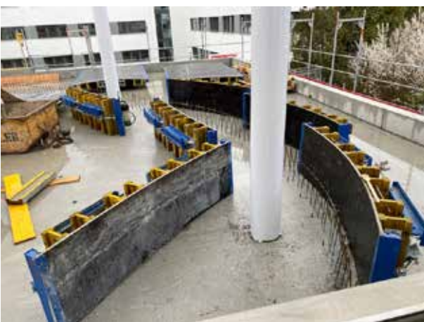
Der äußere Sockel der Ellipse im 1. Stock wird verschalt. Zwischen der Decke des Erdgeschosses und dem eigentlichen Boden des 1. Stockwerkes ist Platz für Elektrik und sonstige Versorgungsleitungen.
