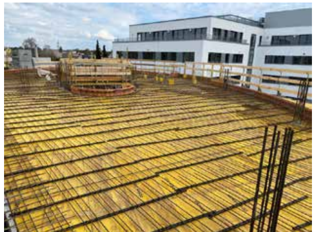
Die erste Lage Baustahl liegt...
