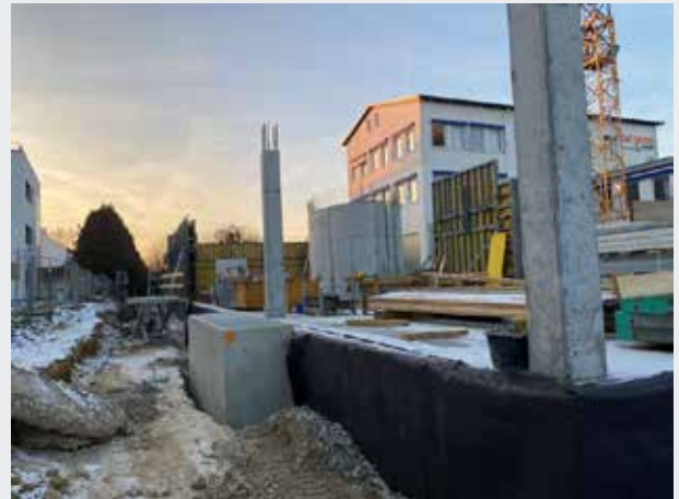
Blick von außen in den Schulungs- und Konferenzbereich. Hier werden keine Außenwände betoniert, sondern es stehen lediglich Betonsäulen, zwischen denen Glaswände für ein offenes Ambiente sorgen werden.
