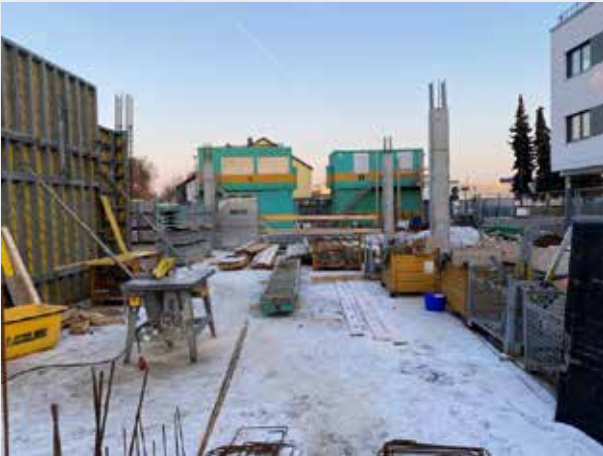
Hier werden ein Abstellraum und eine Küche für die davor liegenden Schulungs- und Konferenzräume entstehen.
