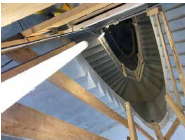
Blick von oben ins Treppenhaus
