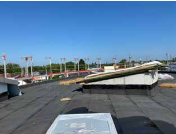
Noch wird das Treppenhaus durch Folien abgedeckt. Später kommt das Licht durch eine große Glasabdeckung ins Treppenhaus.
