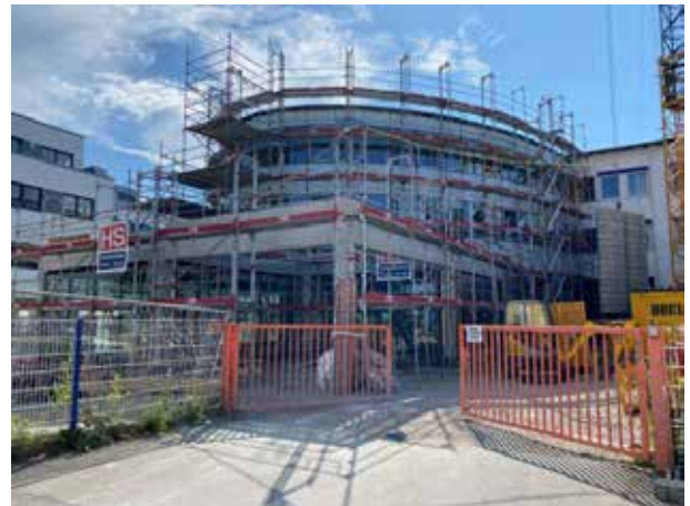
Die meisten Fassadenelemente sind schon an Ort und Stelle – aber noch fehlen die vielen Abdichtungen
