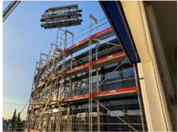
Die Rahmen für das Glasdach oberhalb des Treppenhauses schweben ein.
