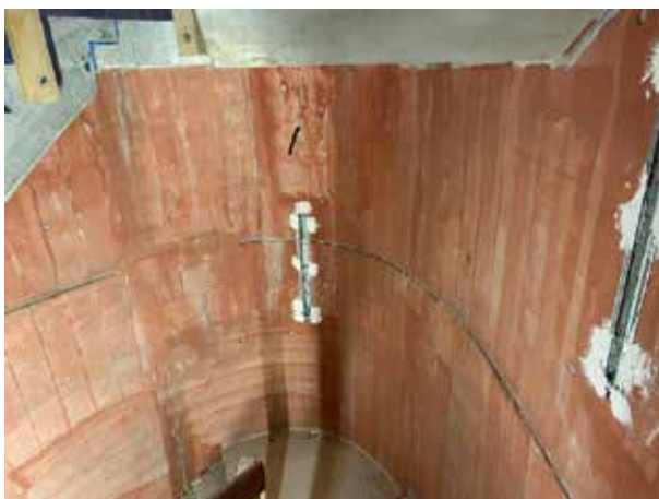
Das Treppenhaus wartet noch auf das Verputzen. Bisher ist es nur grundiert.
