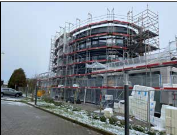
Im Außenbereich wurde verputzt und gestrichen, gerade noch rechtzeitig vor dem Wintereinbruch.
