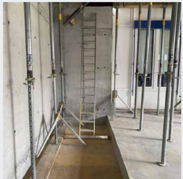
An dieser Stelle wird einmal der Lagerautomat stehen, der vom Keller bis zur Decke des Erdgeschosses reichen wird.
