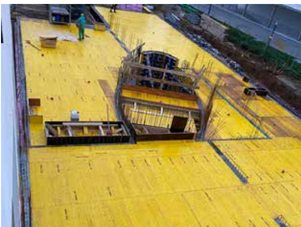
Die Verschaltung für die gesamte Kellerdecke ist fertig. In der Ellipse kann man die "Brücke" erkennen, auf der man von einer Seite des Treppenhauses zur anderen gelangt. Jetzt sind als nächstes die "Stahlflechter" am Zuge.
