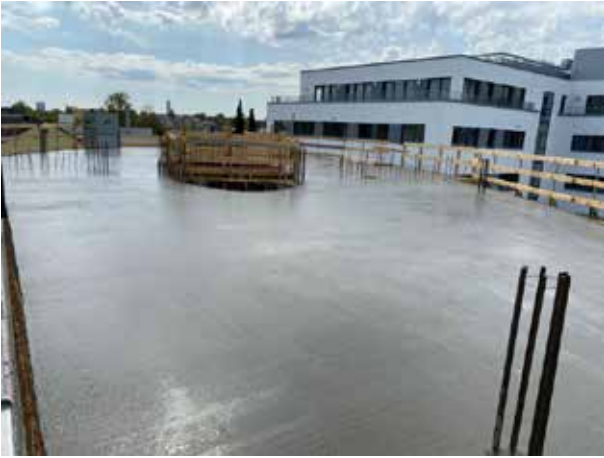
Es ist geschafft: die Decke des 1. Stockwerks ist fertig.
