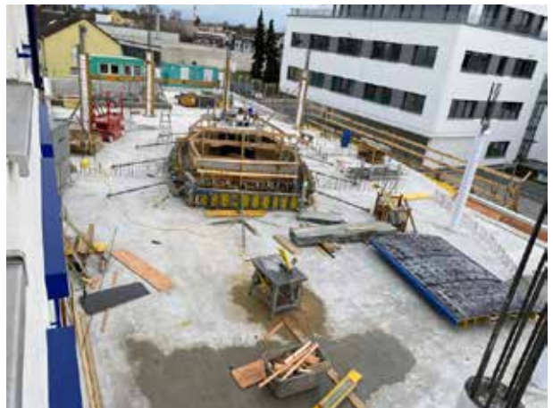
Die "Brücke" über das Treppenhaus ist fertig.
