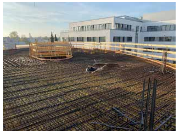
... bis man vor lauter Baustahl die Schalbretter gar nicht mehr sieht. Aber jetzt ist alles fertig zum Betonieren.
